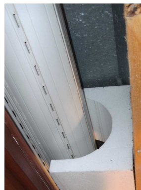
Bestands-Rollladenkasten mit einem Muster des Sanierungssystems „Grupor® S“. Der verbleibende Raum zwischen der Oberseite des „Grupor® S“ und dem Bestandskasten wird nach Systemangaben mit PUR ausgeschäumt
