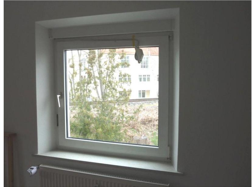
*Fertig eingebaute Laibungsdämmung.*
